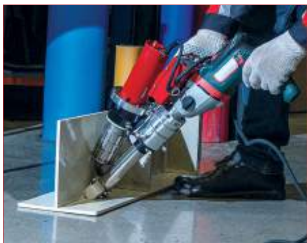
Сварка углов, стыков
