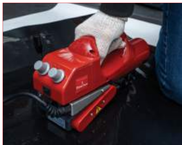
Сварка геомембраны
